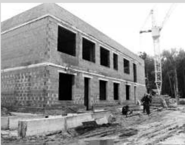
Строительство нового детского сада «Золотой ключик» в самом разгаре. Окончание работ запланировано на конец этого года.
