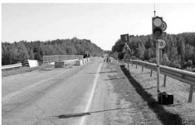
Движение по мосту через реку Яя частично ограничено и регулируется светофорами.
