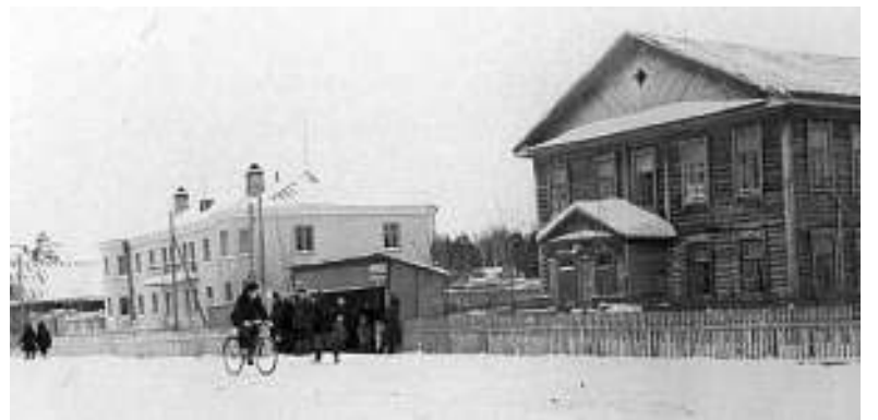
В деревянном здании на улице им. Ленина в 60-е годы находилась поликлиника.
