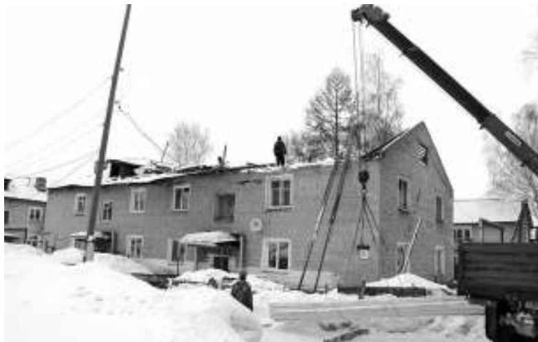
На крыше дома №35 по ул. АВПУ сразу же после ЧП начался ремонт.
