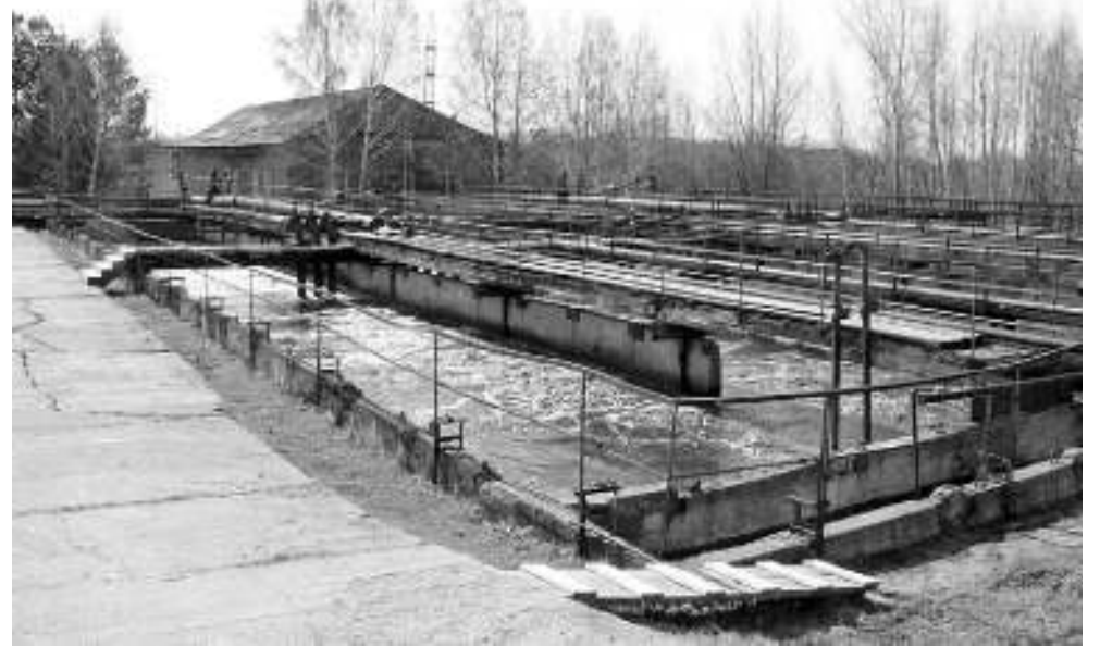
Очистные сооружения давно устарели.
