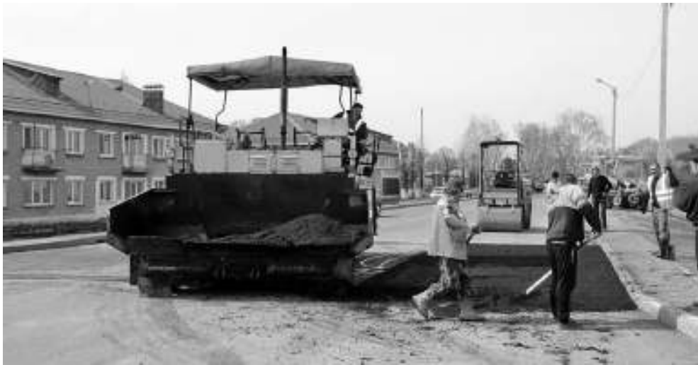
Дан старт ямочному ремонту на улице 9 Мая.
