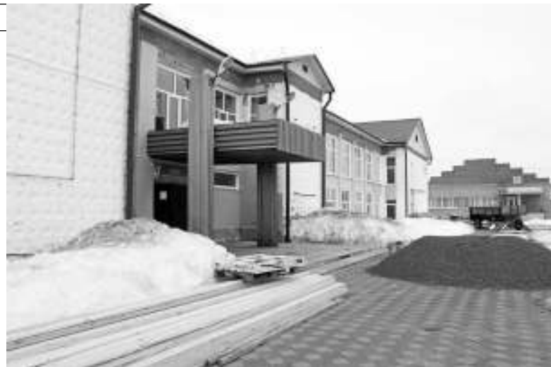
Первым делом строители приступили к ремонту фасада здания Дома культуры.
