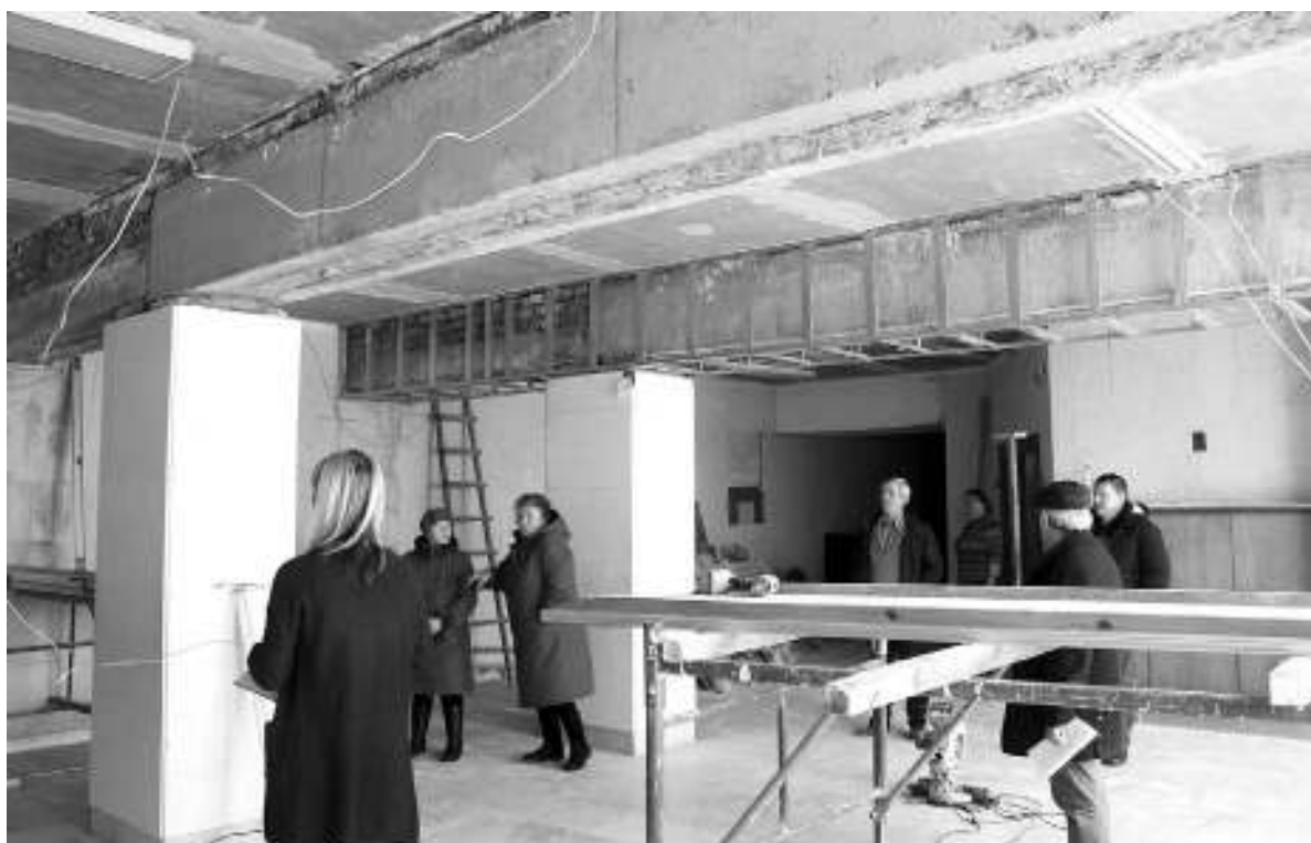
Комиссия осмотрела все помещения, чтобы определить, какие из них нуждаются в первоочередном ремонте.
