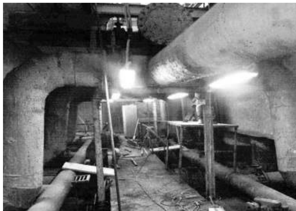
Начало демонтажа старого трубопровода под фильтрами на станции водочистки.
