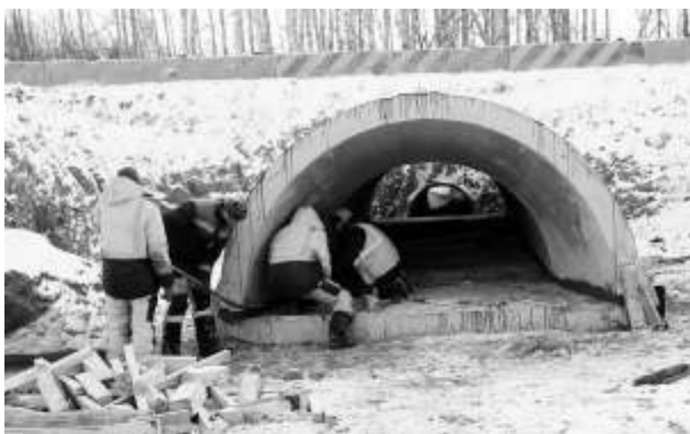
Эта железобетонная водоотводная труба заменит прежнюю.
