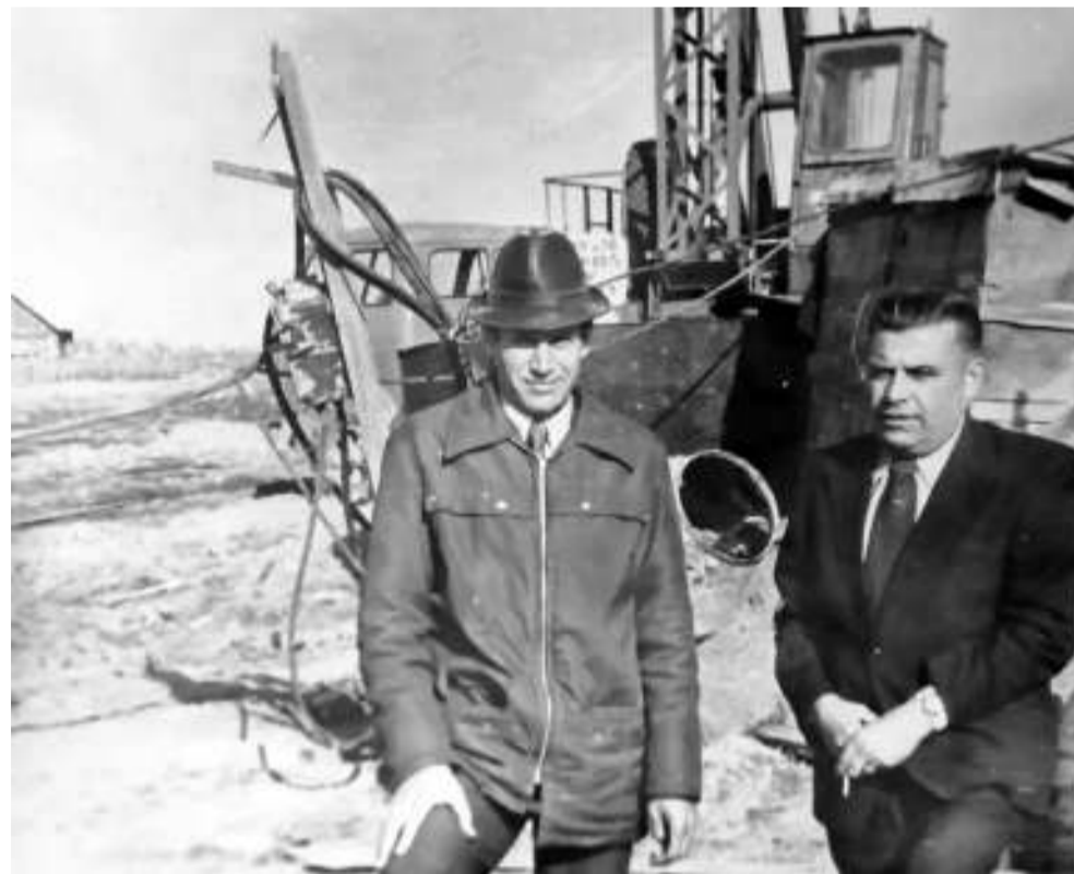
Иван Иванович Савельев (справа) и главный архитектор Владимир Григорьевич Балдин на строительстве телецентра. 70-е годы.
