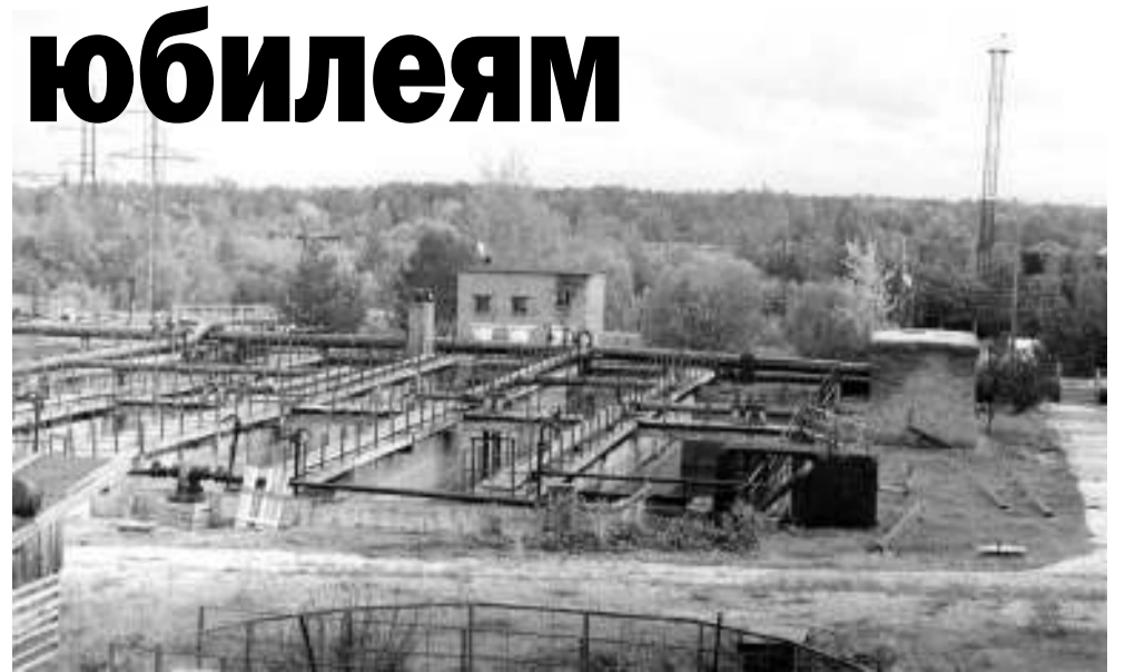
Очистные сооружения Асиновского лесопромышленного комбината введены в эксплуатацию в 1972 году.
