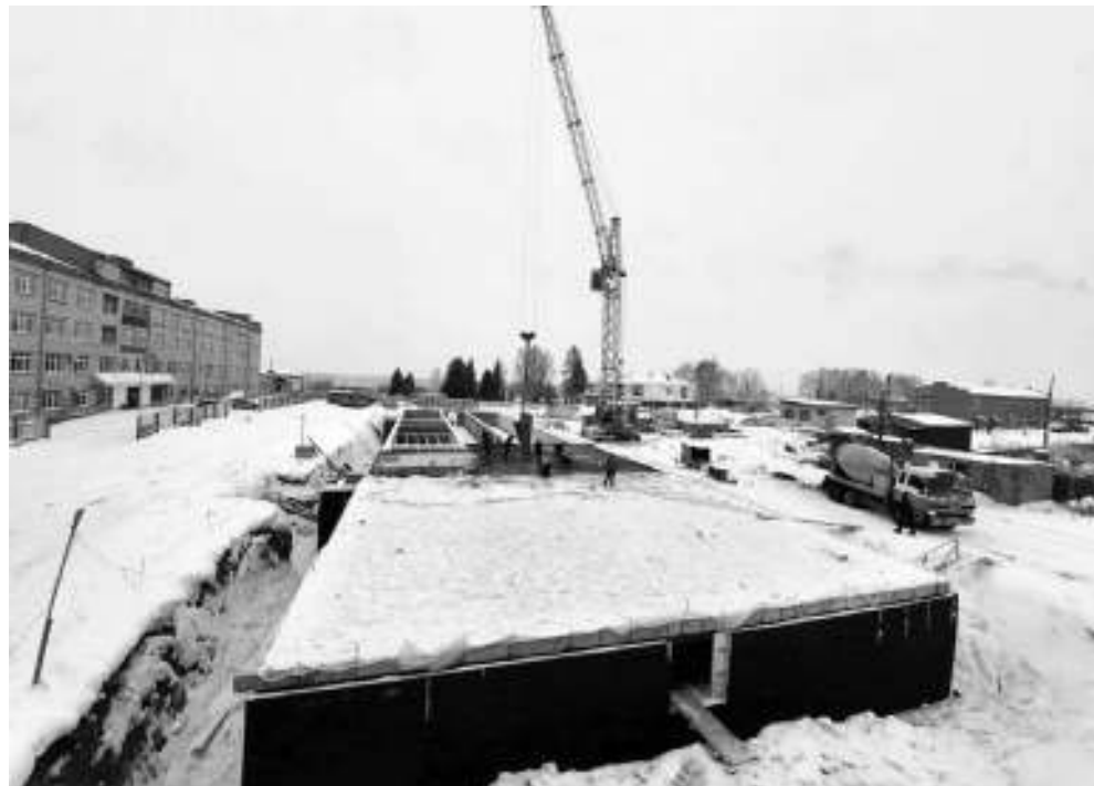
Идёт строительство детской поликлиники.
