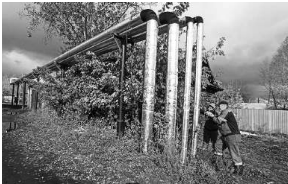
На теплотрассах работают сетевики.
