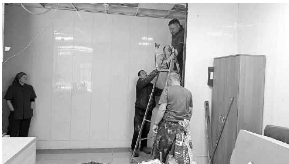
Идёт ремонт на первом этаже, где будет оформлена зона ожидания с раздевалкой.
