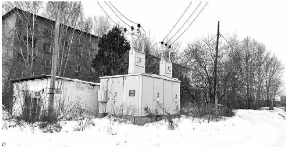
По указанному на сайте адресу вместо пансионата — трансформаторная подстанция и гараж.
