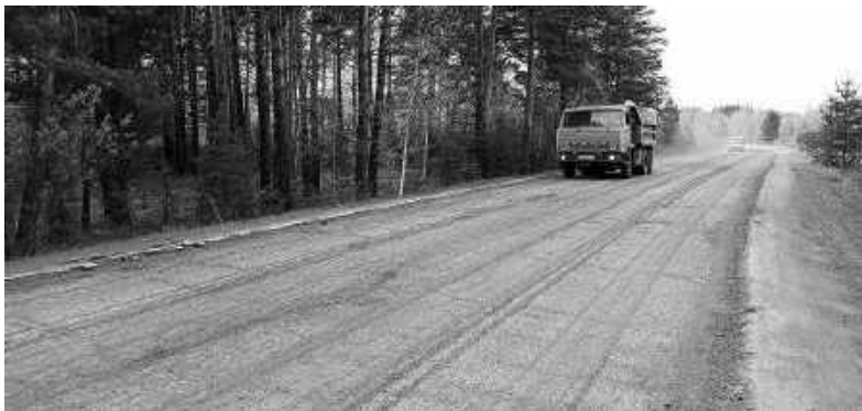
Идёт ремонт дорожного полотна на улице Хвойной.
