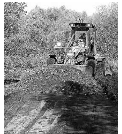
На отсыпку дороги в районе мичуринских ушло 180 тонн щебня крупной фракции.
