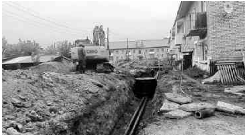
Идёт ремонт теплотрассы на улице П.Морозова.
