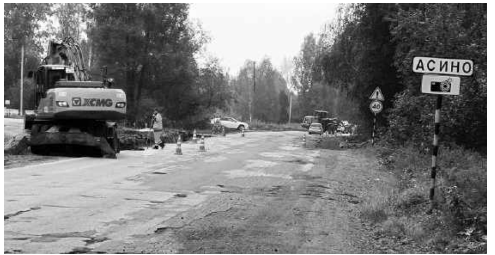
Ремонтные работы ведутся на разных участках трассы, в том числе в районе ПМК-16, где демонтируют старые тротуары и обустривают обочины. Как заверили нас подрядчики, через пару недель здесь будет лежать асфальт.
