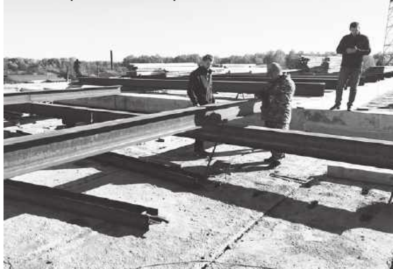
Ремонт крыши Ягодного ДК строители должны завершить к 15 ноября.
