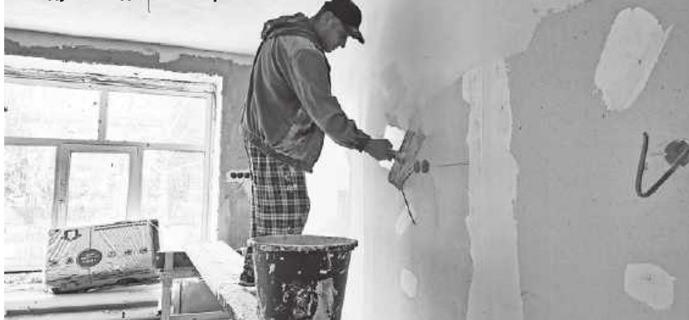
Ведутся отделочные работы.
