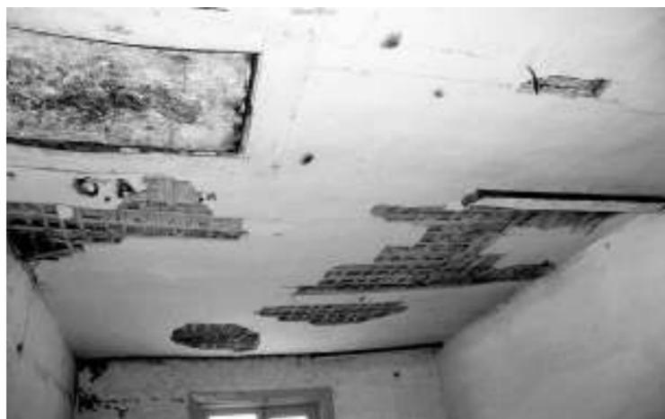
Прогибы, трещины имеются во всех квартирах дома, а в подъезде — обвалившаяся штукатурка и дыры в потолке.
